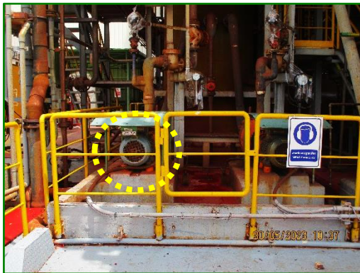
ภาพที่ 2.4 เครื่องสูบน้ำสำหรับไอรกรดของ Scrubber
