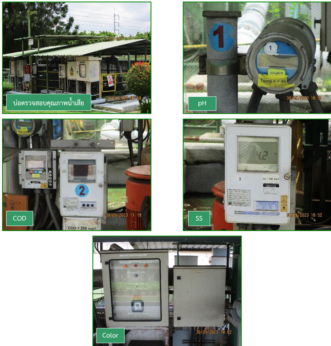
ภาพที่ 2.8 บ่อตรวจคุณภาพน้ำเสียแบบอัตโนมัติ ก่อนระบายเข้าสู่ระบบบำบัดน้ำเสีย ส่วนกลางของนิคมอุตสาหกรรมดับบลิวเอชเอ ตะวันออก (มาบตาพุด)
