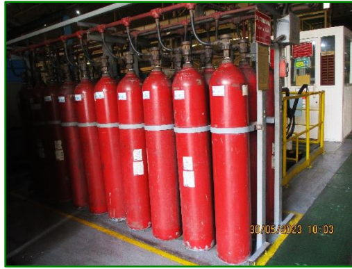
ภาพที่ 2.26 ระบบดับเพลิงด้วยก๊าซคาร์บอนไดออกไซด์ (CO 2 ) ของเครื่อง EDT
