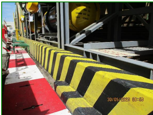
ภาพที่ 2.34 คันคอนกรีตป้องกันการหกรั่วไหล ของแอมโมเนีย
