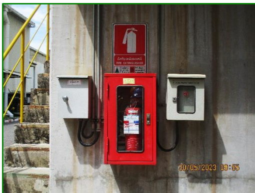
ภาพที่ 2.39 ถังดับเพลิงชนิดผงเคมีแห้งบริเวณพื้นที่จัดเก็บแก๊สโมเนีย
